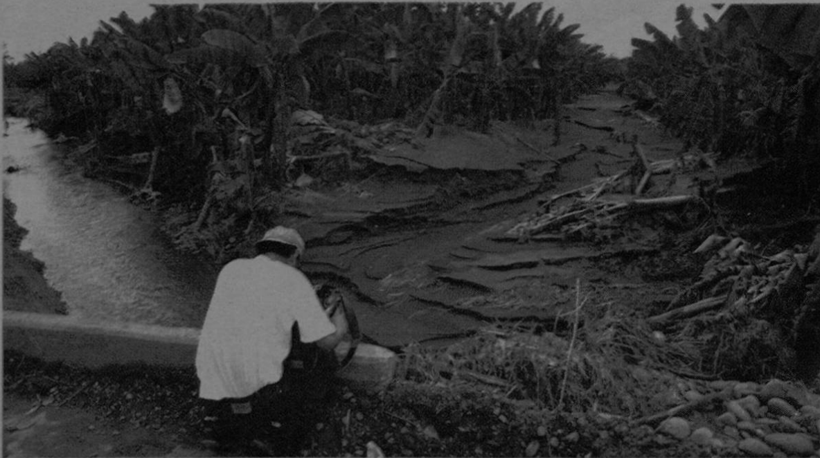
Las fuertes lluvias en la zona atlántica ocasionaron graves daños en las carreteras y la agricultura.
